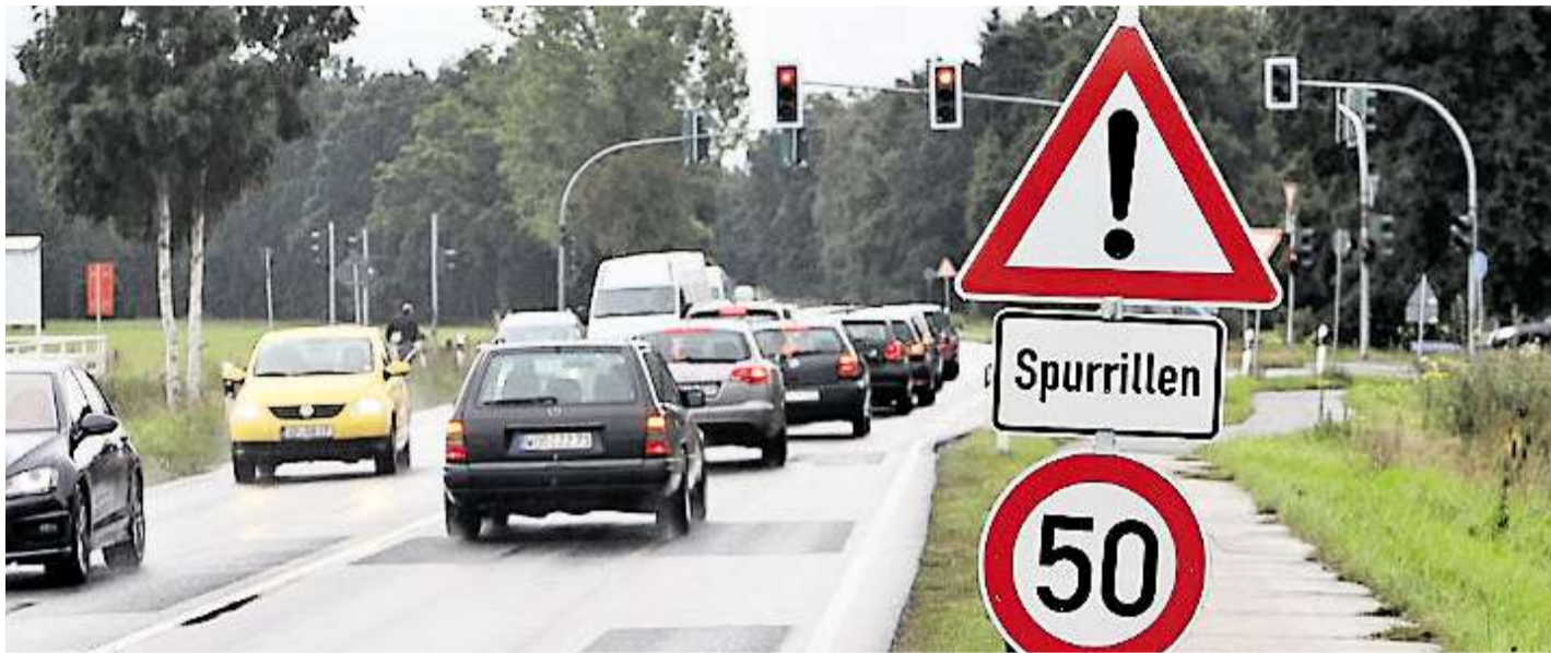
Ein Sorgenkind: Die Tangente hat aktuell an vielen Stellen Schäden – bald beginnen die Sanierungsarbeiten.
