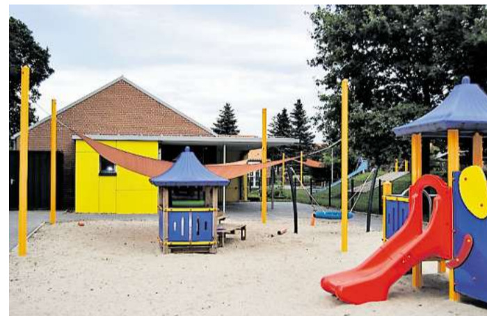
Awo-Kita Grußendorf: Die Außenfassade des Anbaus soll rot werden. Der Anbau soll Ende Februar fertig sein.
