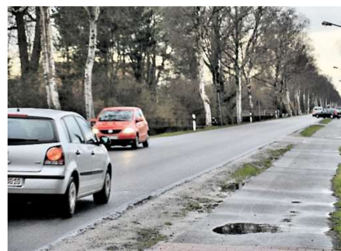
Radweg an der Dorfstraße: Der erste Bauabschnitt der Sanierung soll in diesem Jahr über die Bühne gehen. Chavier (Archiv)
